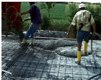
Рис. 15: Укладка защитного слоя бетона в виде самоуплотняющегося бетона и вибробетона
