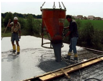
Рис. 15: Укладка защитного слоя бетона в виде самоуплотняющегося бетона и вибробетона
