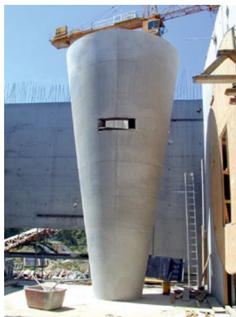
Рис. 13: Укладка самоуплотняющегося бетона
